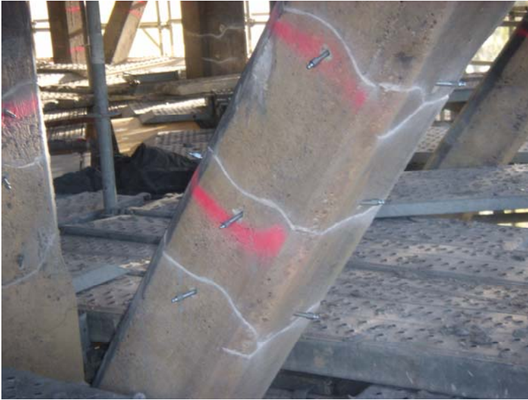
Fig. 3 Inyección de las fisuras
