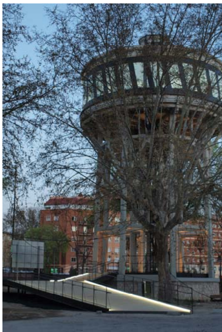
Fig.7 Vista de la pasarela iluminada
